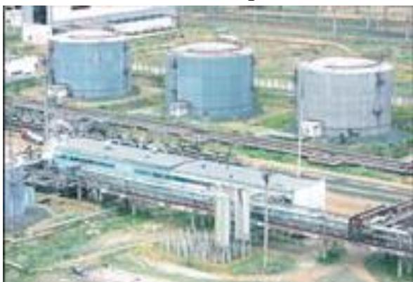
Для непрерывности работы предусмотрен десятидневный резервный запас угля в объеме 150 тысяч тонн. Растопочное мазутное хозяйство располагает приемно-сливной эстакадой на 16 цистерн, мазутонасосной и открытым складом мазута, состоящего из 6 наземных резервуаров общей емкостью 39 тысяч тонн.
